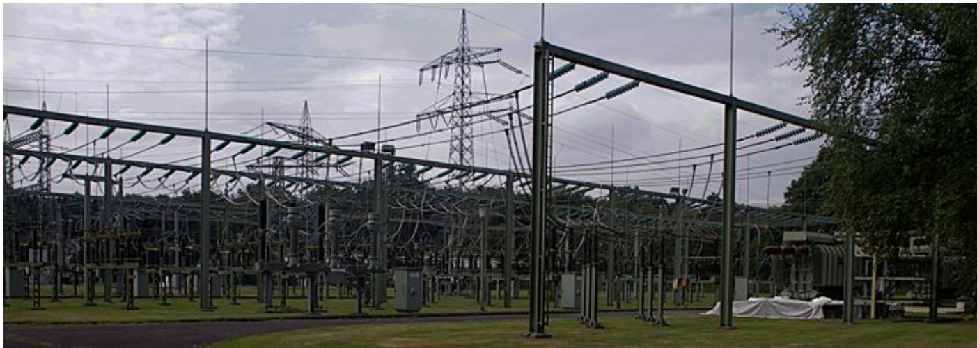
Bild: Umspannanlage; die zentrale und die dezentrale Energieversorgung ergänzen einander; EEZ Energie Energiewirtschaft Zukunftsenergien
