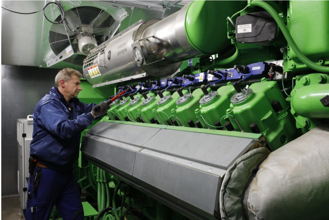
Bild 3: Foto BHKW; EGLV
