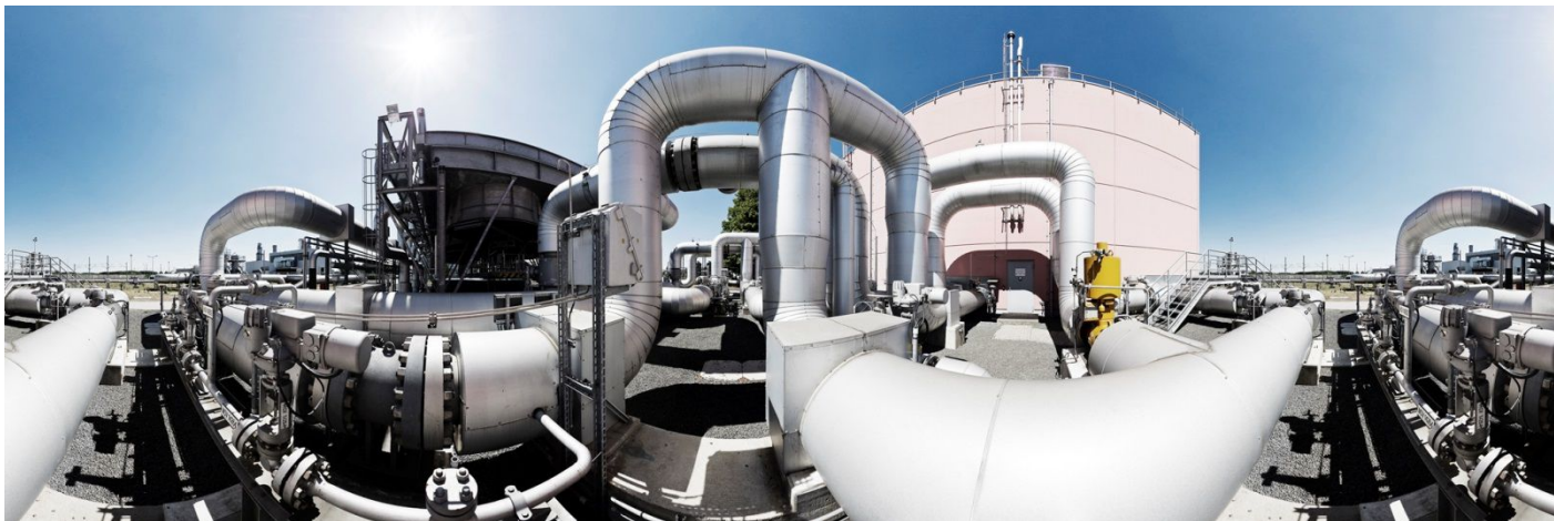
Bild: Verdichterstation; OGE
