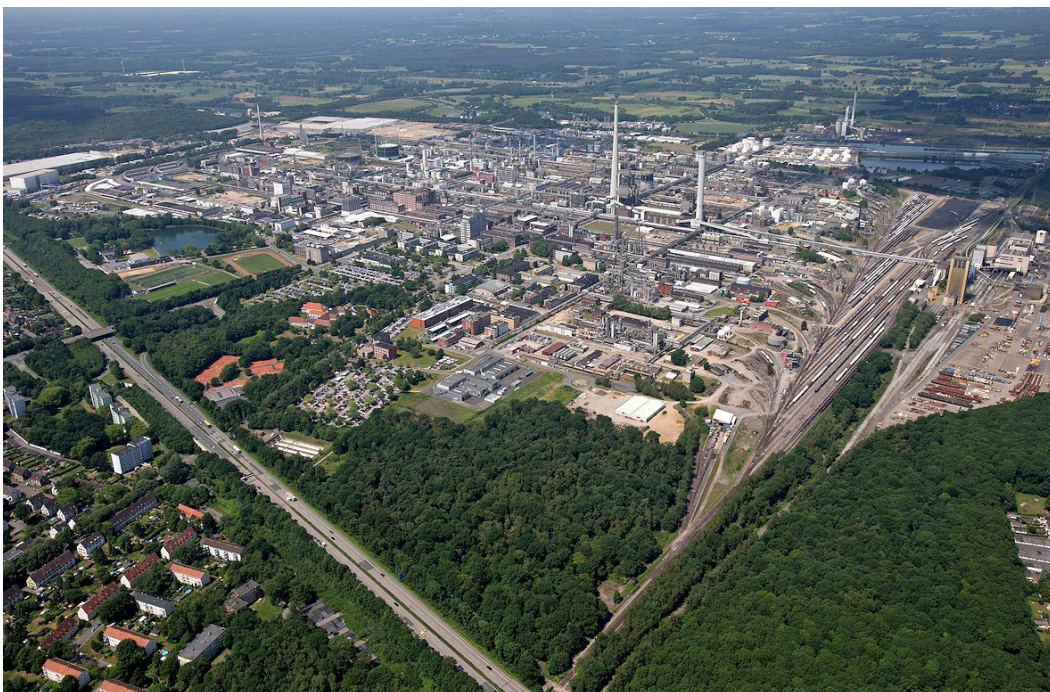
Bild: Chemiepark Marl; Evonik Industries AG
