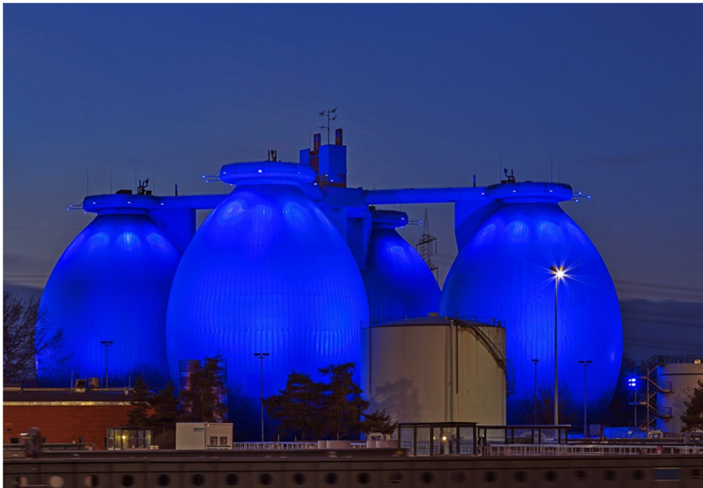
Bild 2: Foto ZSB bzw. Faulbehälter; EGLV
