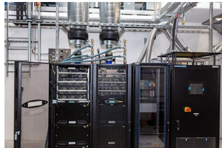
Bilder: Elektrolyse und Brennstoffzellen Fa. Hydrogenics aus Gladbeck im; Anwenderzentrum H 2 Herten
