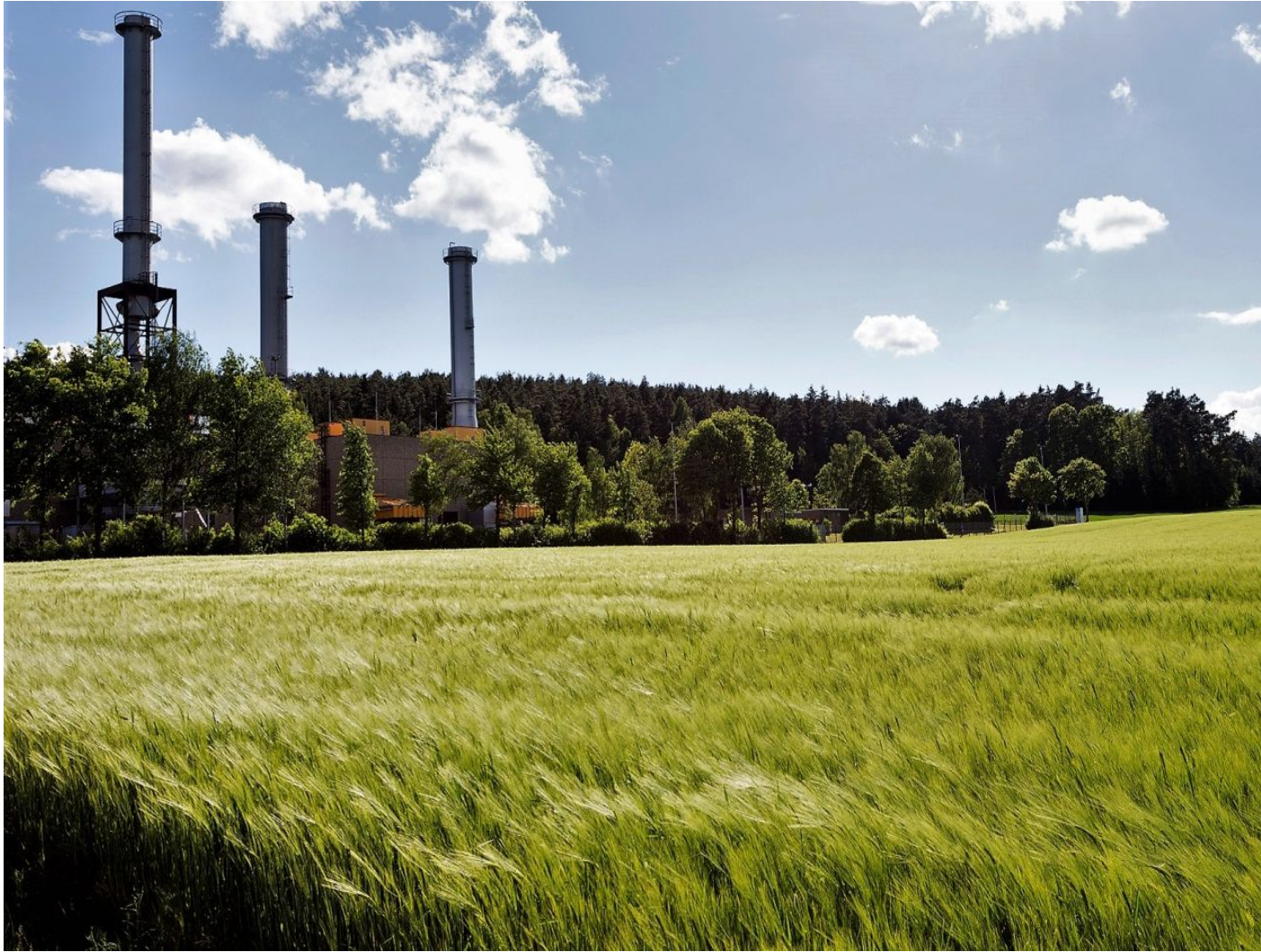
Bild: Verdichterstation; OGE
