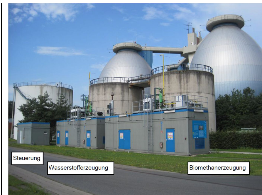
Bild 6: Containeraufstellung der EuWaK-Anlage; EGLV
